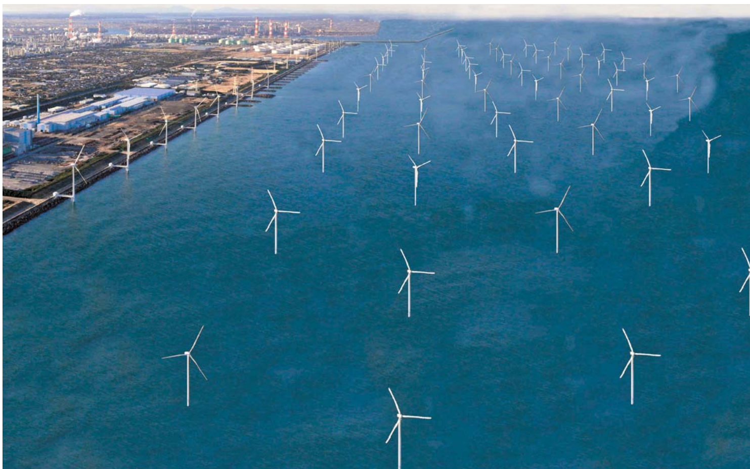
鹿島コンビナートのある神栖市沖に建設される洋上風力発電施設の完成イメージ
