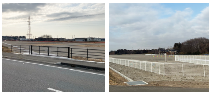
造成中のエリア（令和7年12月撮影）
