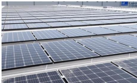
環境負荷低減への取り組みとして、施設屋根面に約6メガワットの太陽光発電設備を設置し（2025年3月より発電開始）、自家消費を行うとともに余剰電力の自己託送を行う計画です。
