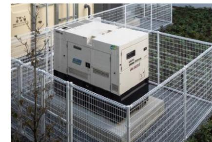
停電時に防災センター機能・1~3階メインコアWC・事務所電源等の機能上必要な設備を維持するため、非常用発電機（168時間稼働）を設置します。
