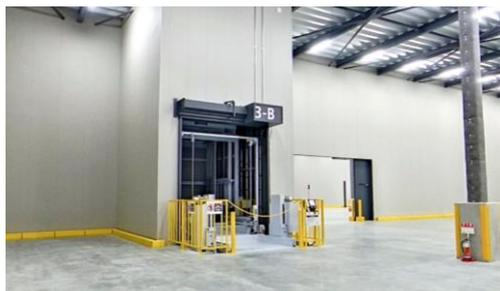
各階車路は柱スパン14m、高さ5.5mを確保。バースシャッター高さは4.5m、バースは奥行14.5mあり、45ftトレーラーも荷捌き可能です。倉庫内は11.0×10.0mの柱スパン、1階は5.5m、2・3階は6.3mの有効高さを確保。床積載荷重は1.5t/m<sup>2</sup>としています。
