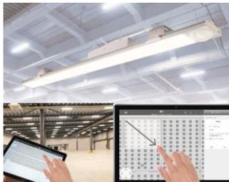
共用部には人感センサー付きLED照明を採用、倉庫内には通常のLED照明比で電力使用量を半減できる高天井用センサー付きインテリジェントLED照明（プロロジス共同開発）を設置し、施設内及び入居企業のESG推進に寄与します。
